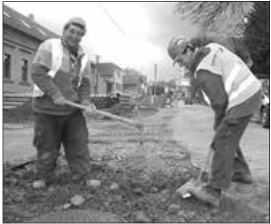
V Panoším Újezdu dokončovala minulý týden parta ze Slovenska kanalizaci v ulici před bývalou hospodou. Foto-peg-
